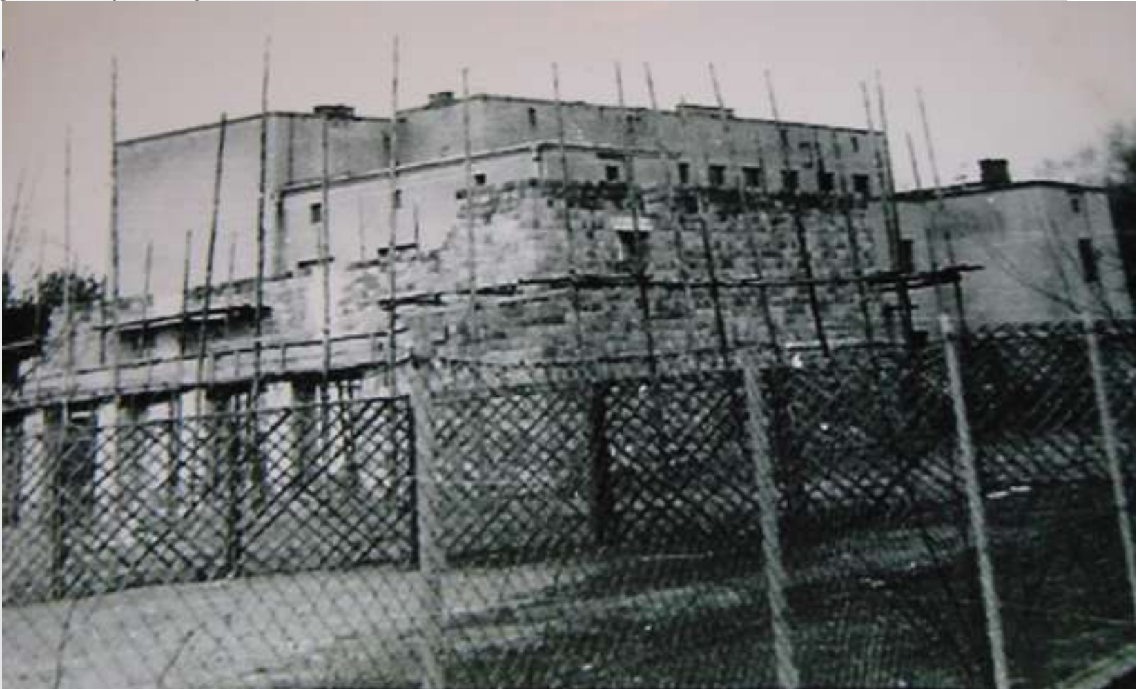
Zdjęcie z roku ok.1962 - przedstawia budowę sali gimnastycznej przy budynku szkoły.
